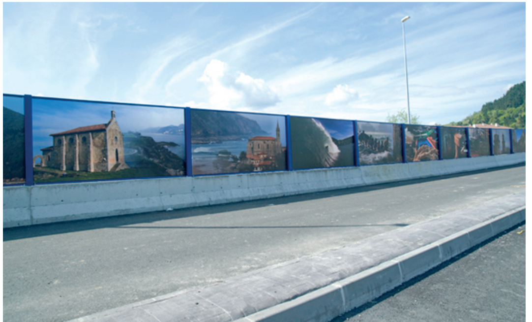
Imagen del recubrimiento gráfico de pantallas acústicas en la variante de Gernika
