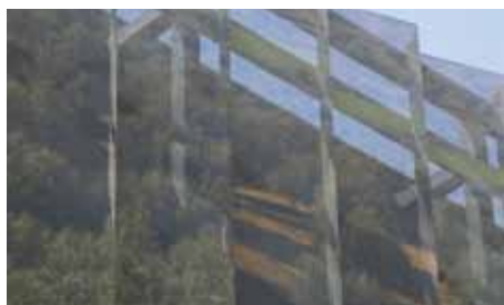
Chapas de acero con triple tratamiento de perforación, plegado e impresión
