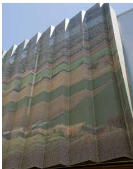
Dinamismo de la fachada de chapa plegada
