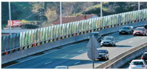
Pantallas acústicas en la A8.
