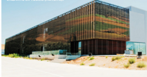
Fachada principal de aceites URZANTE en Tudela (Navarra).
