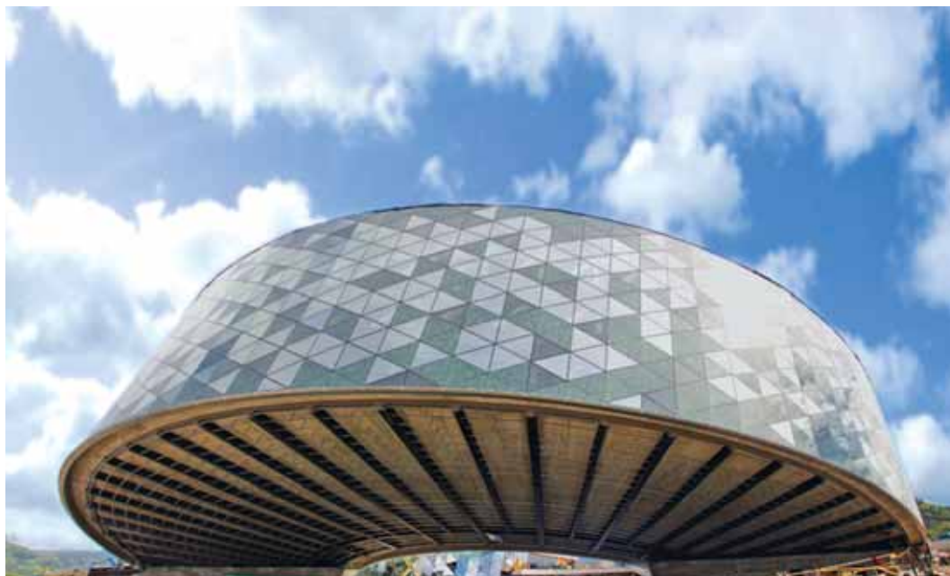
Fachada del espectacular edificio Zero de Orona, que Umetal ha revestido con vidrio laminado UmetalGlass
